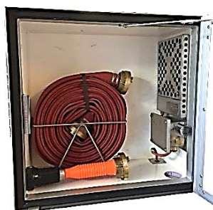
Slangeskap med varme
